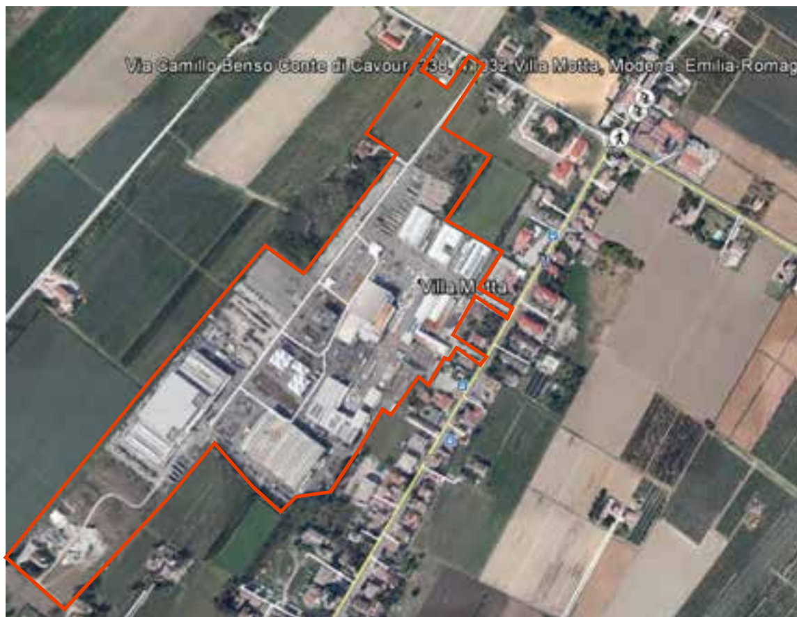
Fig. 1.1: Ripresa aerea dell'area di interesse, tratta da Google Earth.
