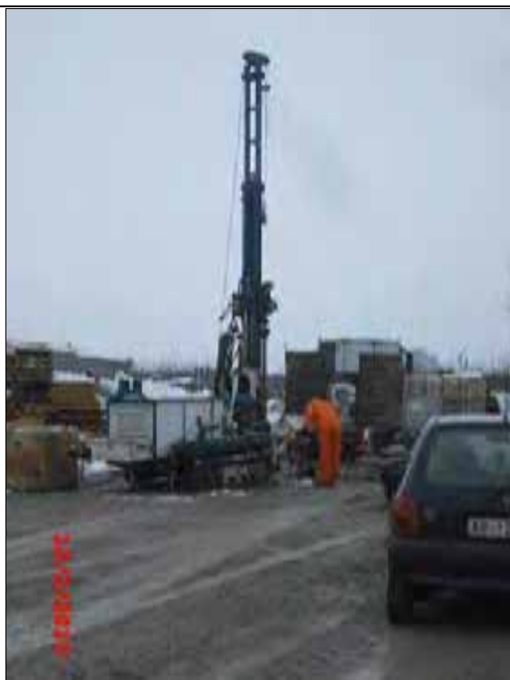
Figura 2.4.2 – Esecuzione del sondaggio S1
