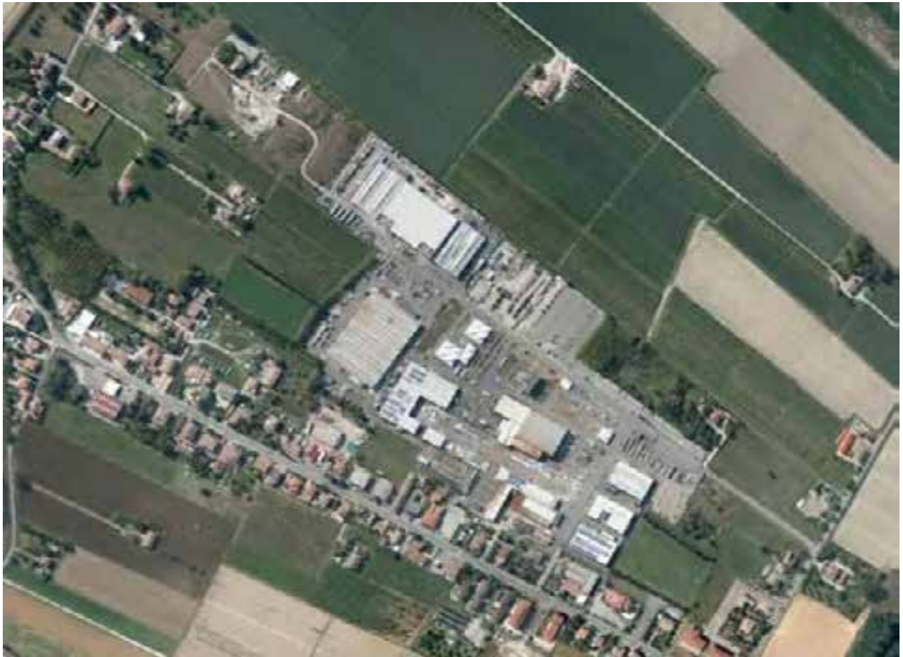
Ortofoto dello Stato di Fatto del Comparto dopo il Sisma di Maggio 2012
