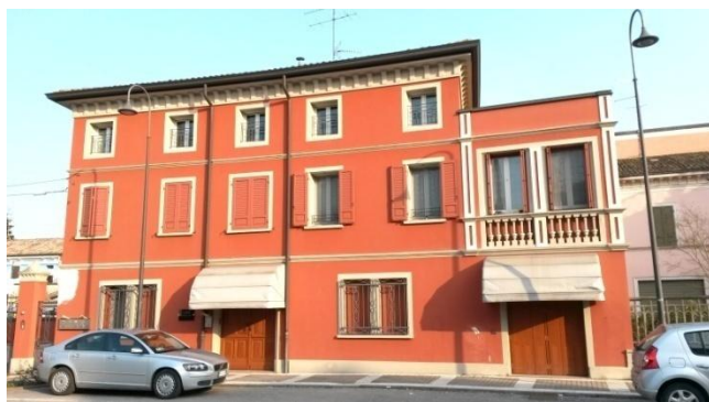
Foto 26 – Unità Edilizia 113 Viale Garibaldi – edificio tinteggiato di recente con colore incongruo
