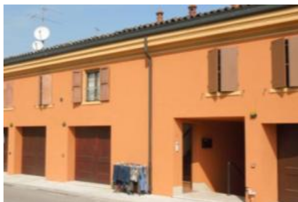
Foto 14 – UMI 32 Via Don Minzoni – tinteggi che hanno coperto le vecchie tinte a calce
