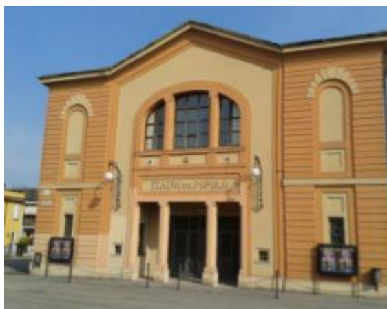
Foto 32 – Unità Edilizia 120 Via Pace – edificio soggetto a vincolo
