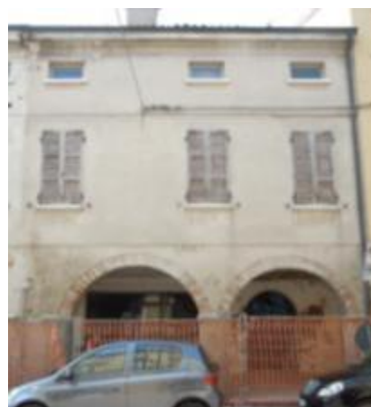
Foto 10 – UMI 26 Via Pace ovest – esempio di casa intonacata non tinteggiata
