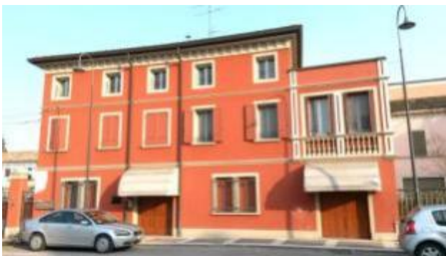
Foto 24 – Unità Edilizia 113 Via Garibaldi – edifici con colori incongrui
