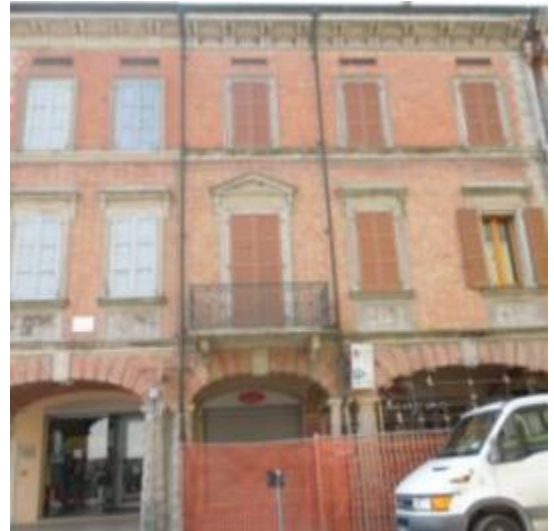
Foto 30 – UMI 30-31-29 Via Pace – edificio “faccia a vista”
