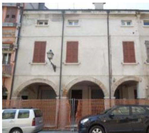
Foto 9 – UMI 27 Via Pace ovest – esempio di casa intonacata non tinteggiata
