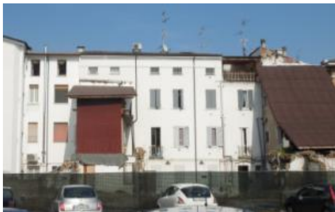
Foto 33 – UMI 67 Piazza Repubblica – edificio da ricostruire
