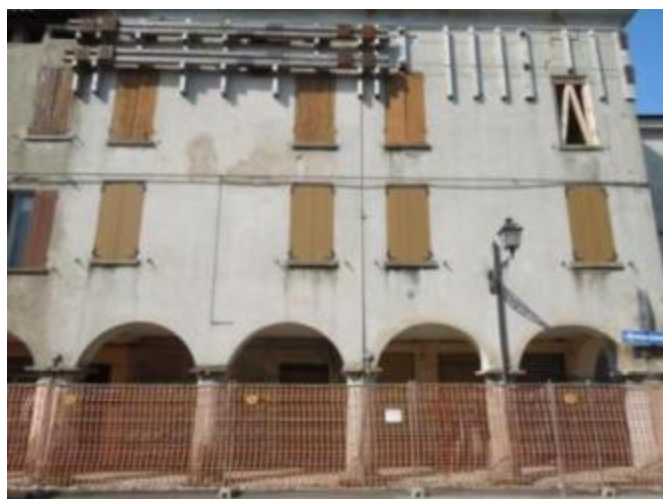
Foto 6 – UMI 5 Via Pace ovest – esempio di casa intonacata non tinteggiata
