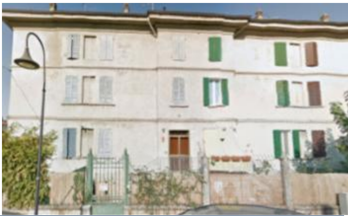
Foto 28 – UMI 51 Via Garibaldi – edificio intonacato e non tinteggiato
