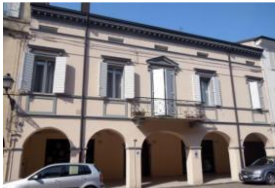
Foto 11 – Unità Edilizia 87 Via Pace ovest – tinteggi che hanno coperto le vecchie tinte a calce
