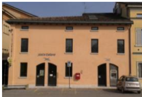
Foto 12 – Unità Edilizia 83 Via Pace est – tinteggi che hanno coperto le vecchie tinte a calce
