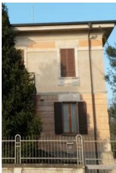
Foto 27 – UMI 53 Via Decime – edificio con tracce di colore
