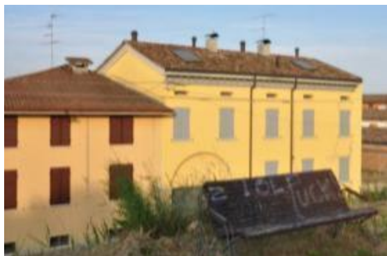
Foto 13 – UMI 24-25 Via Don Minzoni – tinteggi che hanno coperto le vecchie tinte a calce
