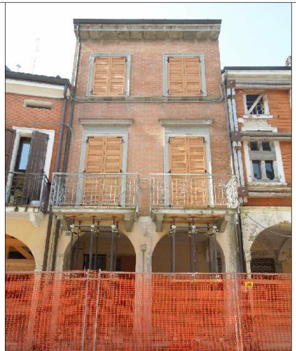
Prospetto su via della Pace n.83-85
