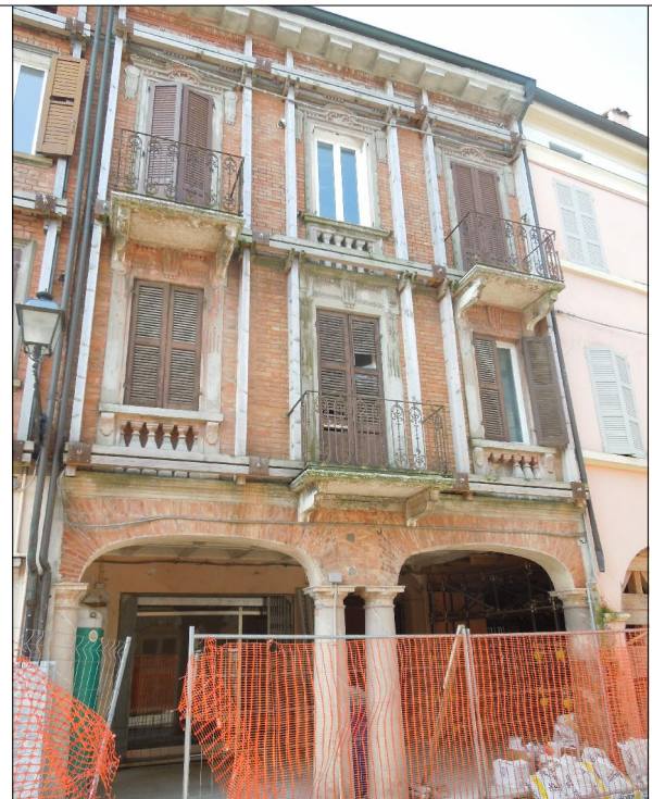
Prospetto su via della Pace n.65-67
