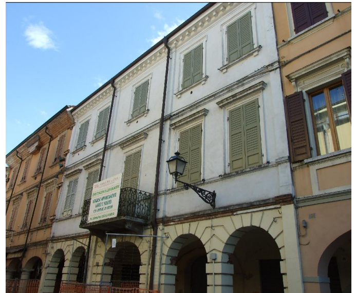
Prospetto su via della Pace n.35-37-39
