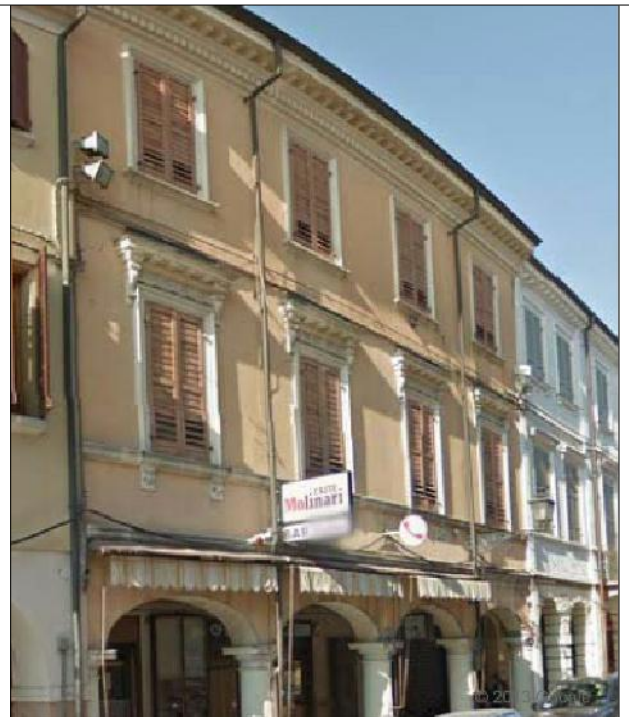
Prospetto su via della Pace N.29-31-33
