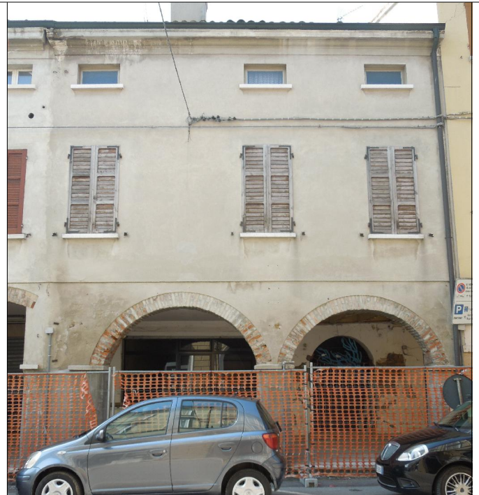
Prospetto su via della Pace n.19-21
