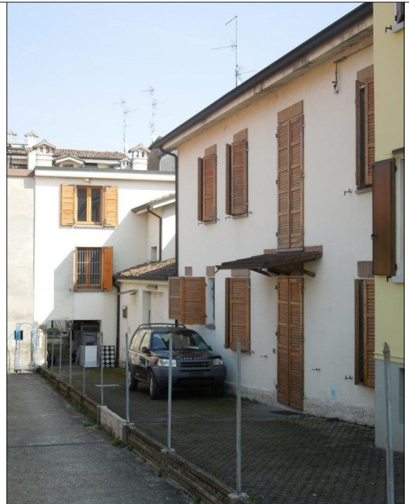
Prospetto su cortile interno
