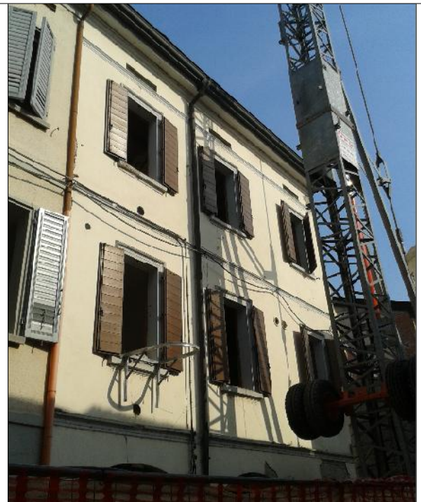
Prospetto su via della Pace n. 62 - 64
