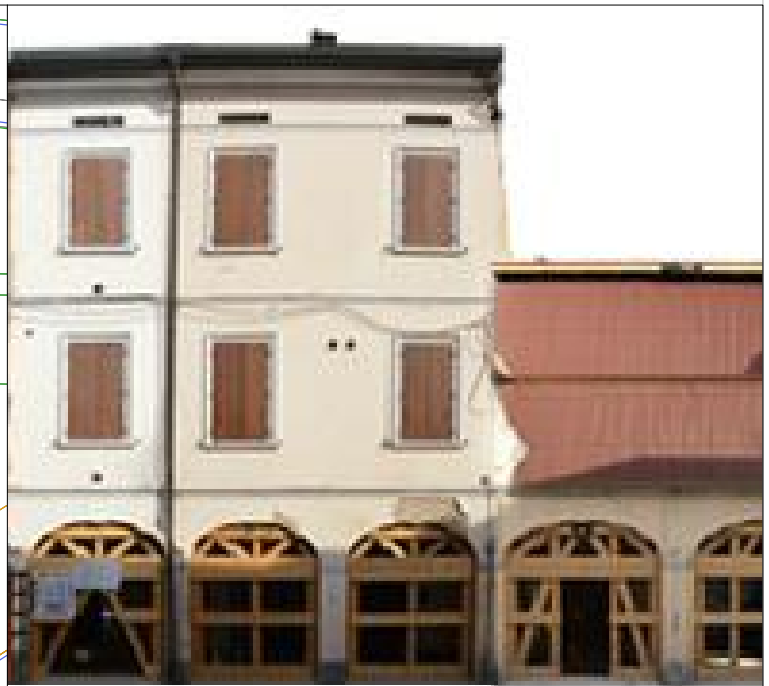
Prospetto su via della Pace n. 58 - 60
