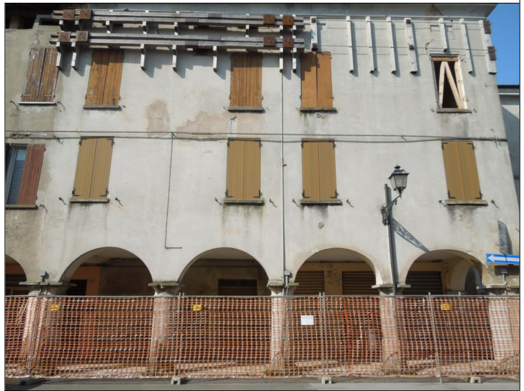
Prospetto su via della Pace n. 127/1-127/2-127/3
