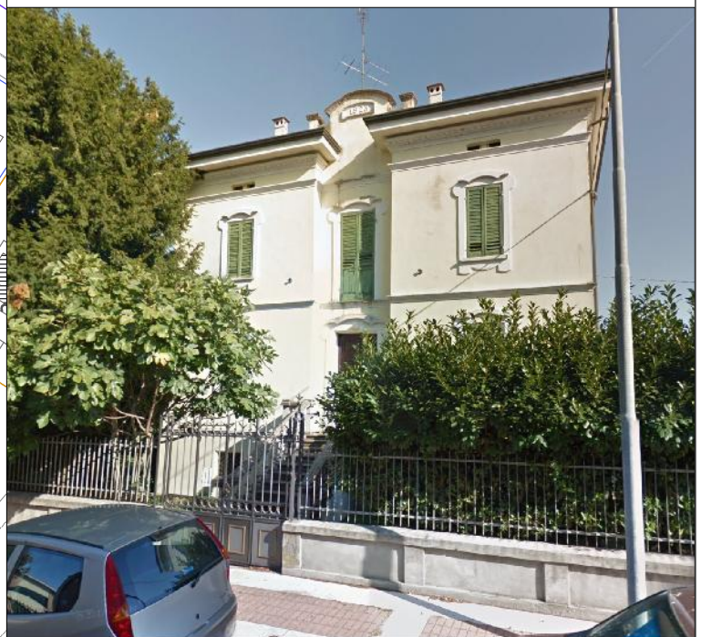
Prospetto su via Decime n. 4
