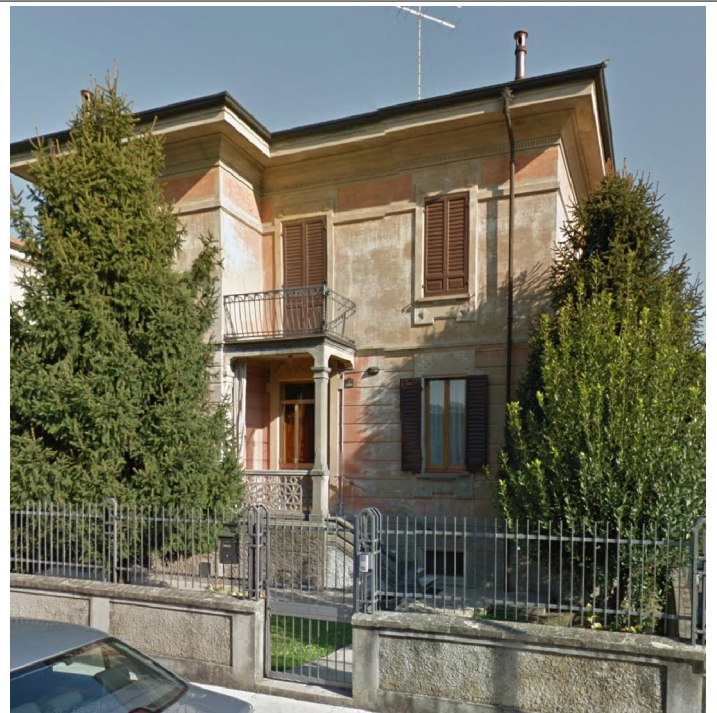
Prospetto su via Decime n. 2/1
