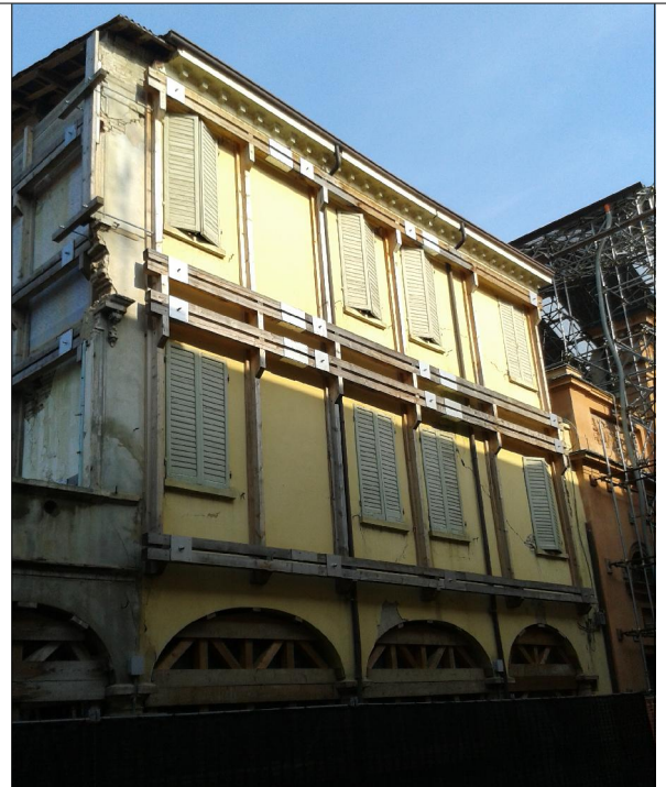
Prospetto su via della Pace n. 20 - 22 - 24
