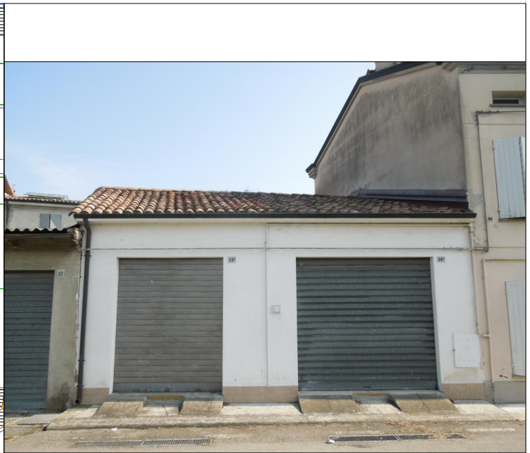
Prospetto su via Don Minzoni n. 36A - 36B
