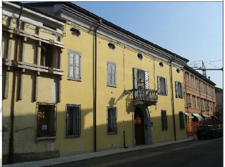
Prospetto su via della Pace n. 82
