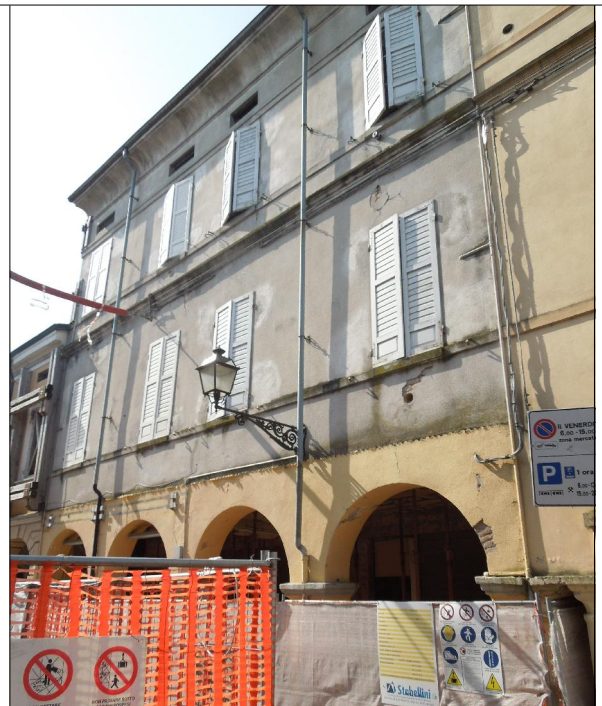
Prospetto su via della Pace n. 101 - 103 - 105
